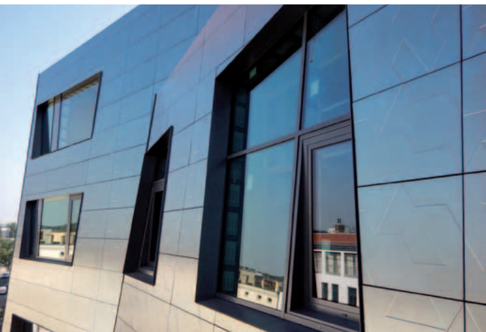
Bild: Ingenieurbüro Franke (5)
