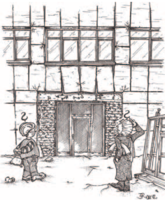
Bild 5: Beim Ausbau von Fassadenplatten kam es zu einem Spannungsabbau in unmittelbarem Bereich des Rückbaus.
