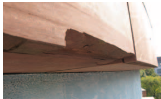
Bild 4: An dieser Fassade kam es zu einem schalenförmigen Abplatzen in Teilbereichen der Natursteinbekleidungen.
